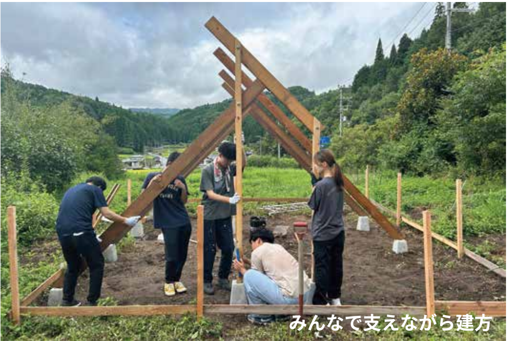
みんなで支えながら建方
